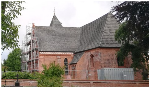
Gerüst auf der Rückseite noch vorhanden, Ostseite bereits abgerüstet.
